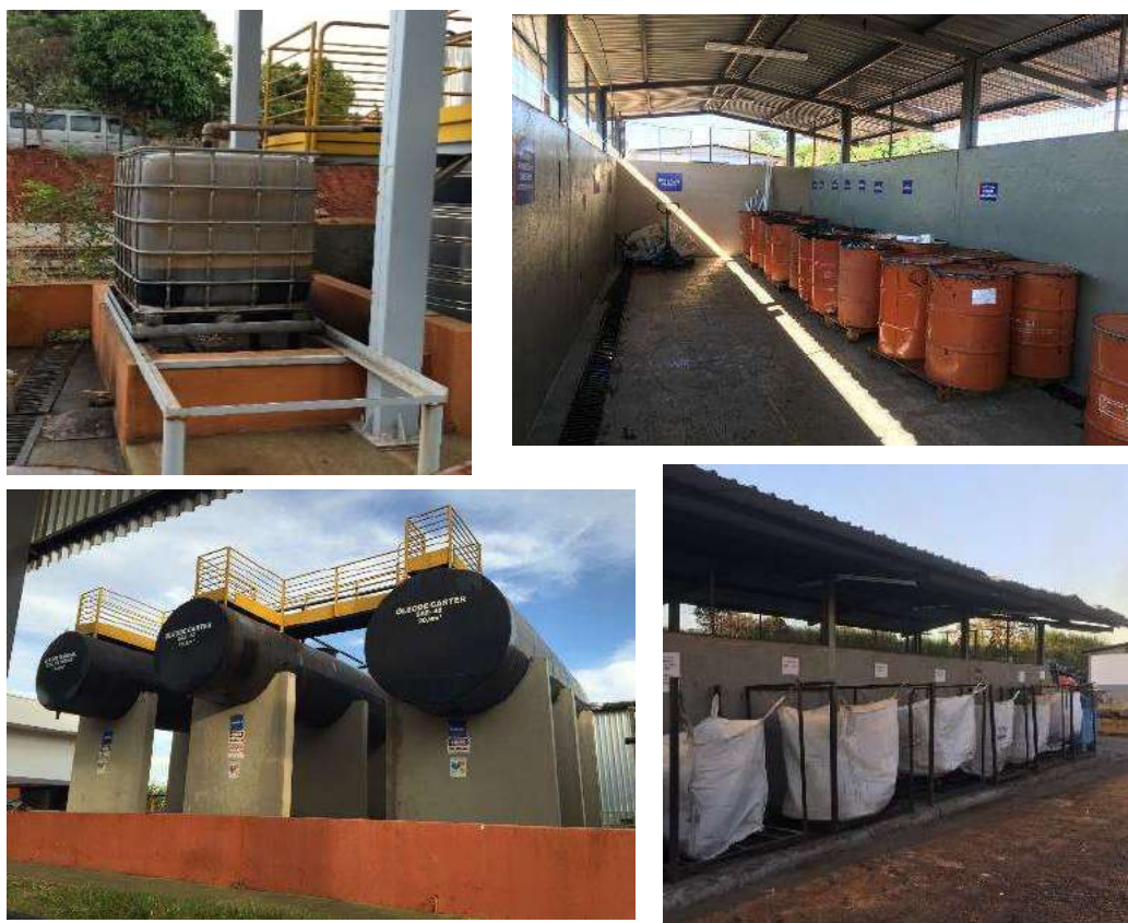
Foto 03: Acondicionamento/armazenamento de resíduos classe I (perigosos).
