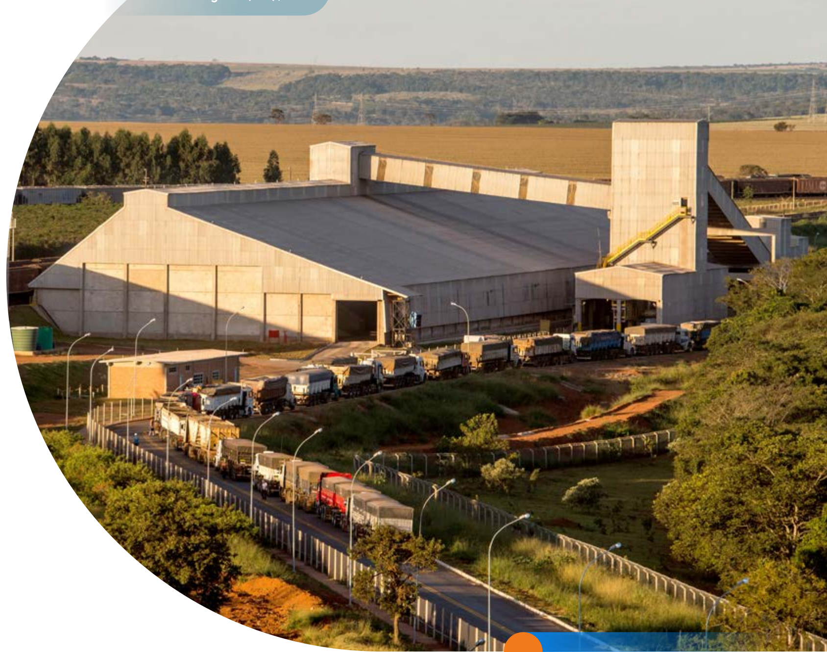
Terminal Integrador Araguari (TIA), MG
